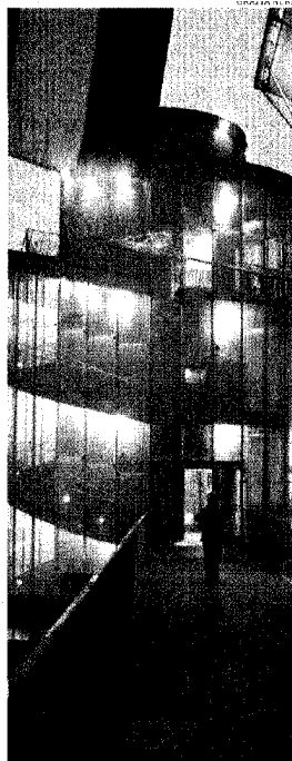
La Fiera in città. Un particolare della struttura del Portello
